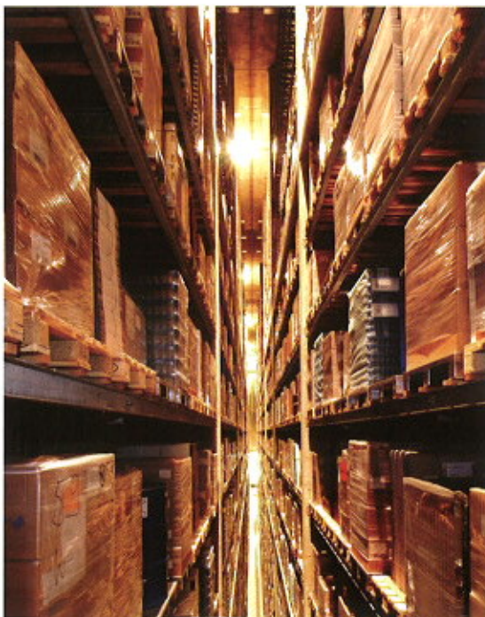
Bild 2 27 000 von insgesamt 32 000 Stellplätzen für die Lagerung von Einsatzstoffen, Packmitteln, Zwischen- und Fertigprodukten auf Euro- und Chemiepaletten befinden sich im temperaturgeführten, automatischen HRL.
