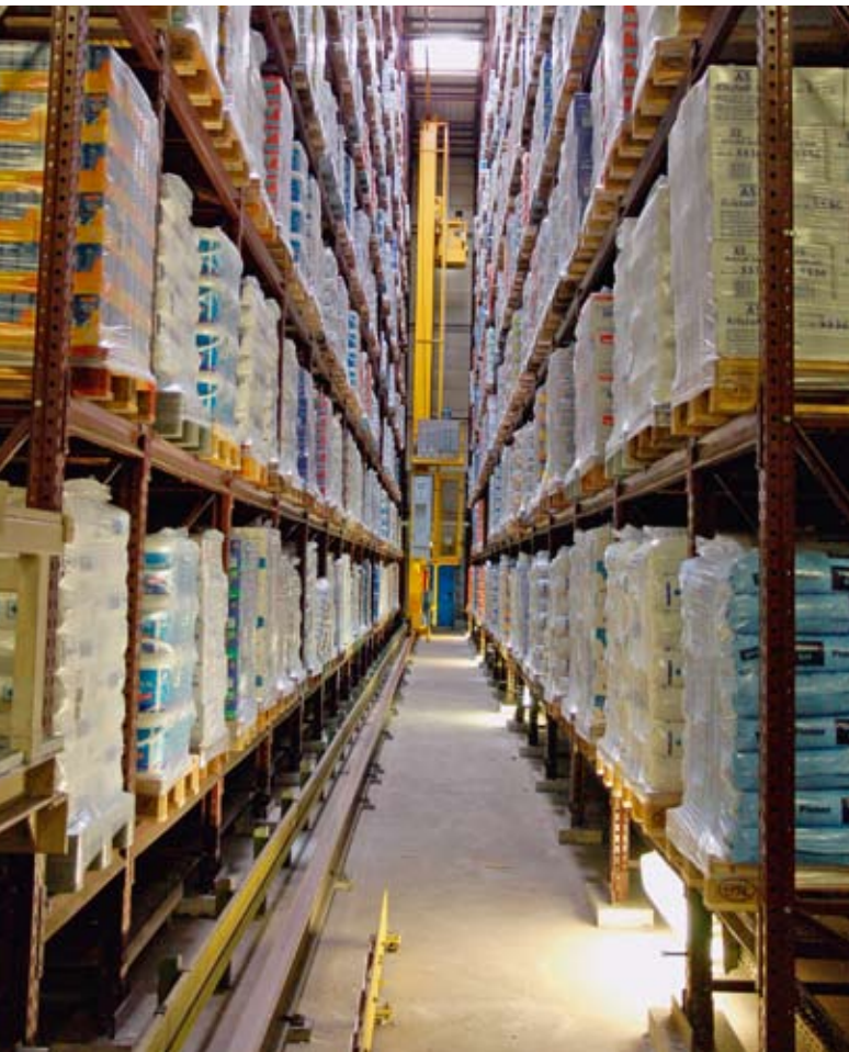
Blick in das im Jahr 2007 modernisierte und seither mit SAP EWM verwaltete und gesteuerte automatische Paletten-Hochregallager.
